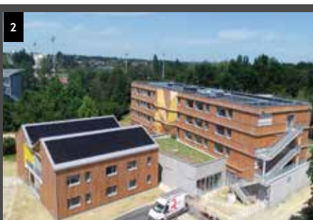
2 - À proximité immédiate de l'internat, la Région a également fait construire via SemBreizh, 4 logements de fonction de type T4 dans un petit collectif d'un étage recouvert de panneaux photovoltaïques.
