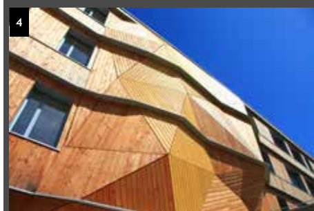
4 - Clin d'œil de Mûrisserie Architecture aux sportifs de haut niveau avec la façade d'entrée qui prend l'apparence d'un mur d'escalade.
